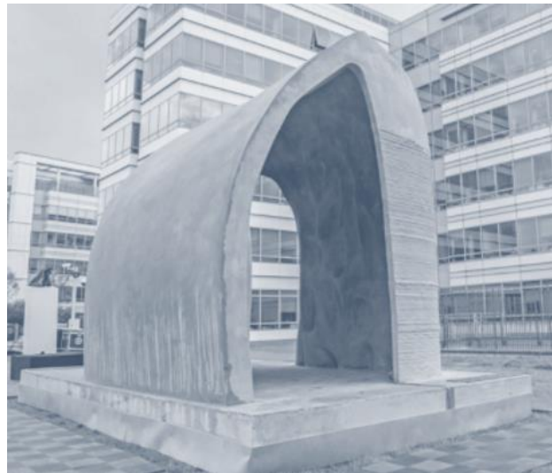
Figura 23 Edificio eseguito con stampante automatizzata in Francia – Fonte: https://plparchitecture.com [ultima visualizzazione 11-12-2024]
